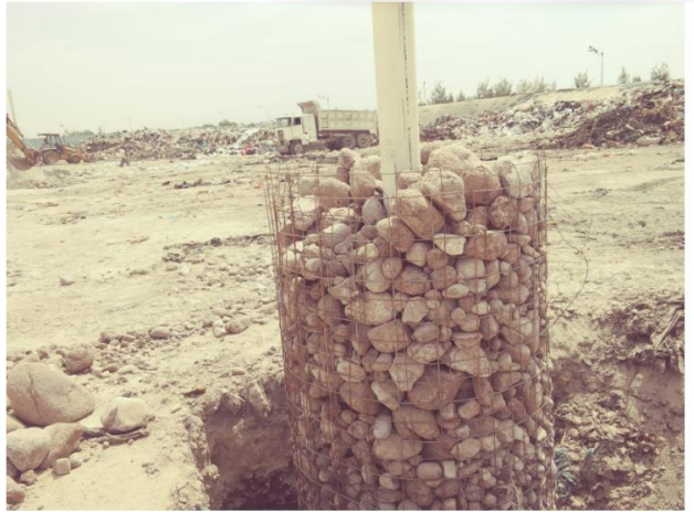
Construcción de pozos de venteo en el Relleno Sanitario
